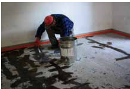
Fot. 5. Szpachlowanie ubytków i bruzd
