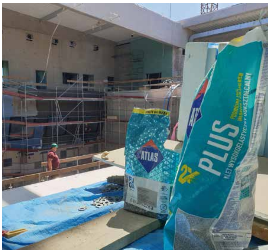
Fot. 3. Podczas budowy obiektu wykorzystano kompleksowe rozwiązania systemowe ATLAS m.in. z kategorii kleje, hydroizolacje, fugi, zaprawy, tynki
