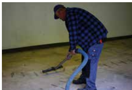
Fot. 10. Odkurzanie powierzchni
