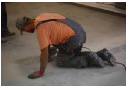
Fot. 9. Szlifowanie nierównych fragmentów podłogi
