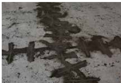
Fot. 6. Podłoga po zaszpachlowaniu
