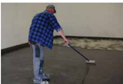
Fot. 7. Gruntowanie powierzchni
