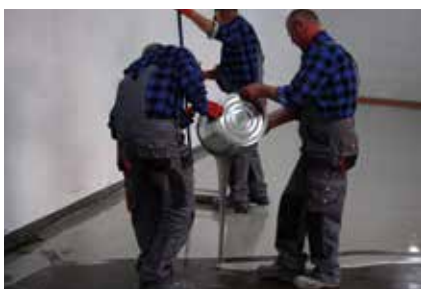
Fot. 11. Wykonywanie posadzki żywicznej
