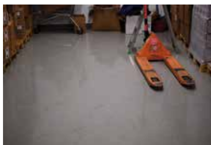
Fot. 12. Podłoga po naprawie w trakcie eksploatacji
