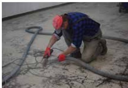
Fot. 4. Wykonywanie bruzd pod zszycie rys w płycie prętami
