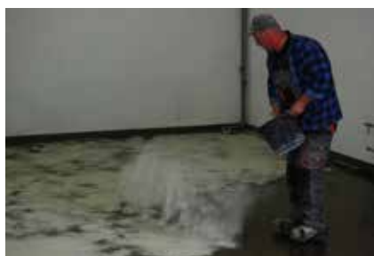
Fot. 8. Posypanie piaskiem kwarcowym
